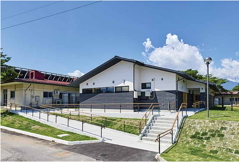
すずらん棟の外観
